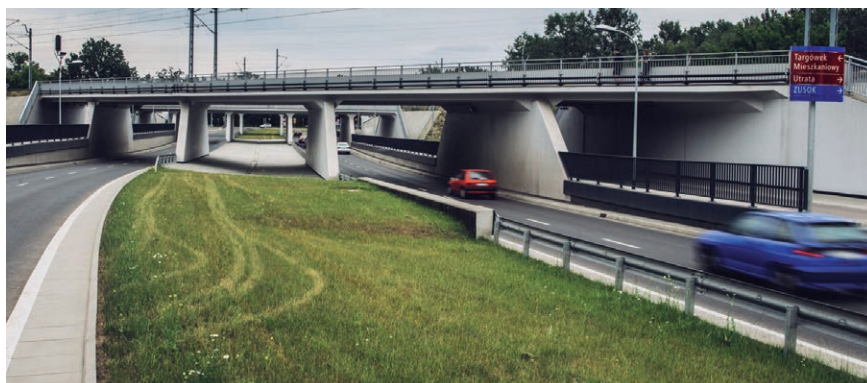
FOT. 1 Trasa Świętokrzyska w Warszawie – uszczelnienie szczelin dylatacyjnych poziomych pomiędzy płytą fundamentową wanny szczelnej a elementami pionowymi konstrukcji tunelu
