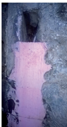
FOT. 2 Uszczelnienie pionowych dylatacji na połączeniu ściany szczelinowej i ściany żelbetowej przejścia podziemnego
