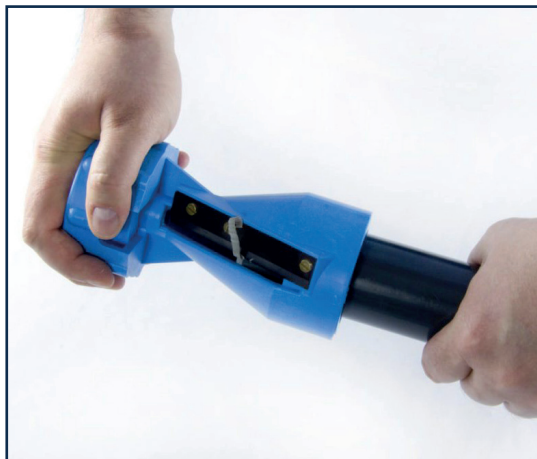
Fazowanie zewnętrznej krawędzi rury
