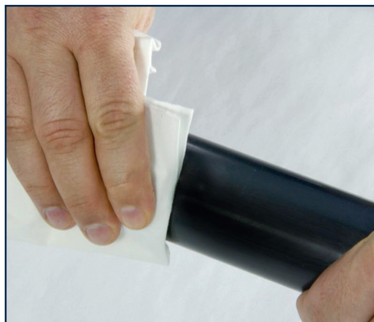
Dokładnie oczyść powierzchnię przeznaczoną do klejenia.
