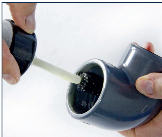
Nanieś na klejone powierzchnie warstwę kleju.
