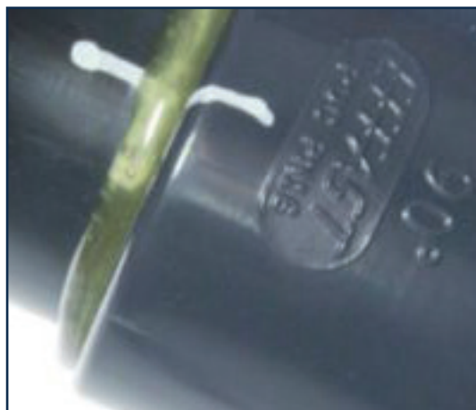
Prawidłowo wykonanie połączenie klejone.
