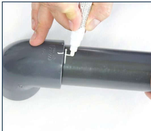
Zaznacz punkt spasowania rury i kształtki.
