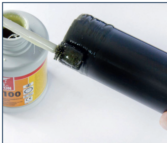
Nanieś na klejone powierzchnie warstwę kleju.
