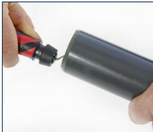
Oczyszczenie wewnętrznej krawędzi rury przed klejeniem.
