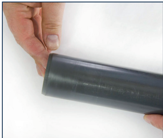
Powierzchnia po prawidłowym wyczyszczeniu powinna być matowa.
