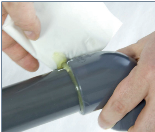
Usunięcie nadmiaru kleju po wykonaniu połączenia.
