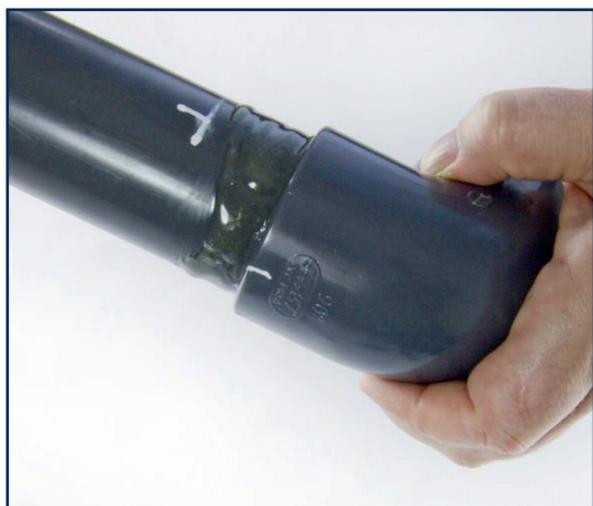
Wsунь łączone części i wykonaj obrót o 15 stopni.
