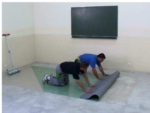
Dociśnięcie wykładziny do podłoża
