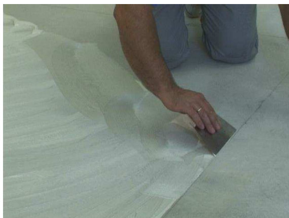
Nanoszenie kleju na podkład
