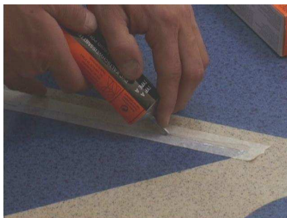
Wprowadzenie żelu do naciętej spoiny
